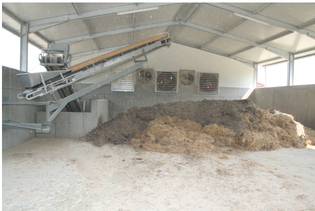
Abbildung 21: Überdachtes Mistlager (© Martin Mayringer, LK OÖ)
