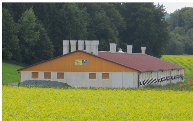
Abbildung 11: Hier wurde der nötige Abstand zu den Wohnhäusern durch die Konzentration der Kamine am Ende des Stalles erreicht. (© Christoph Zaussinger)
