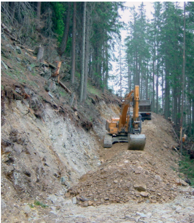
Abbildung 74: Straßenbau im Schutzwald
