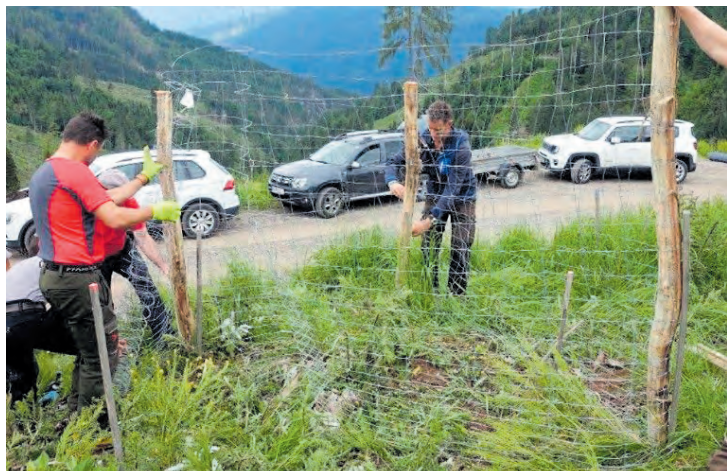
Errichtung eines Kleingruppenschutzes (Dreieckszaunes).
