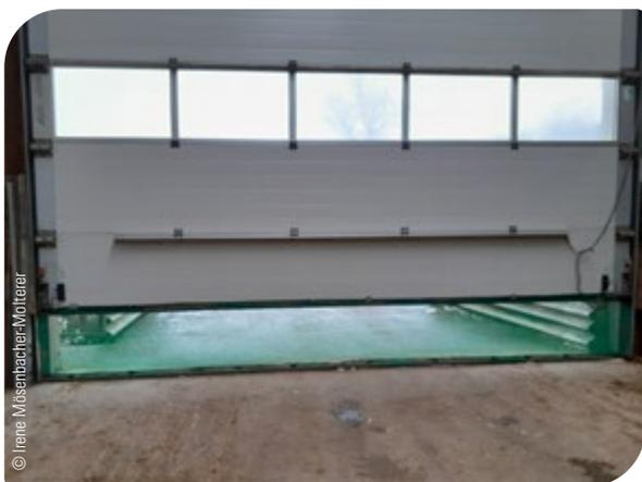
**Abb. 13:** Während der Wintermonate ist auch eine Frischluftzufuhr über Tore am Futtertisch möglich, wobei Windschutznetze die einströmende Luft abbremsen
