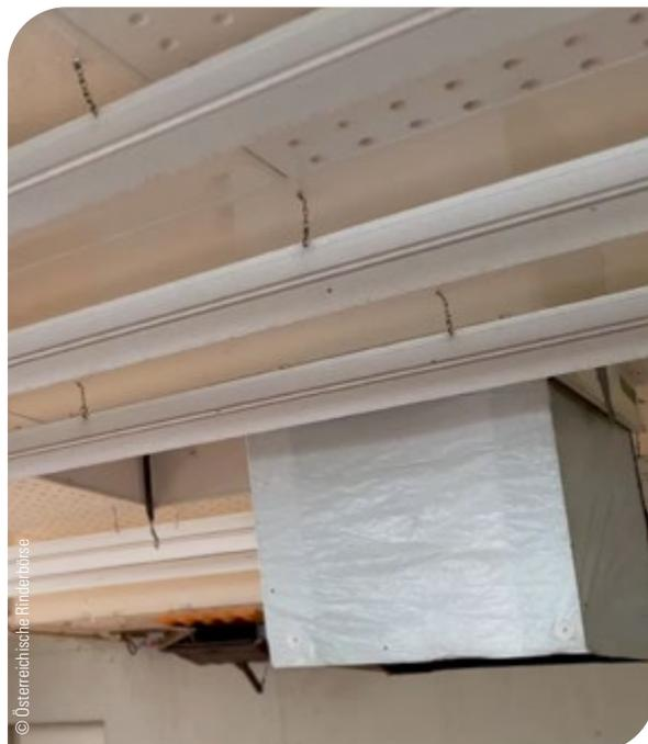
Abb. 23: Die angewärmte Luft gelangt über eine Porendecke in den Stall
