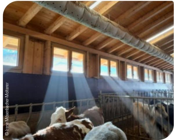
Abb. 11: Schlauchbelüftungen sorgen in Kälberställen für frische Luft
