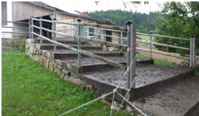
Schrittfreundliche Treppen als Zugang zu Weide
