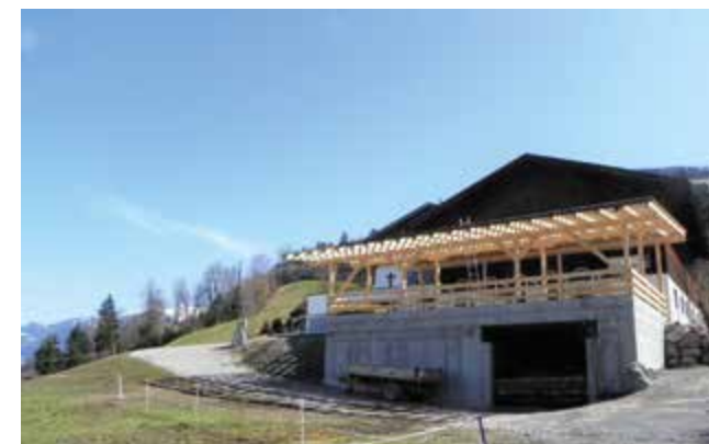
Der Rohbau lässt das fertige Gebäude schon erahnen.
