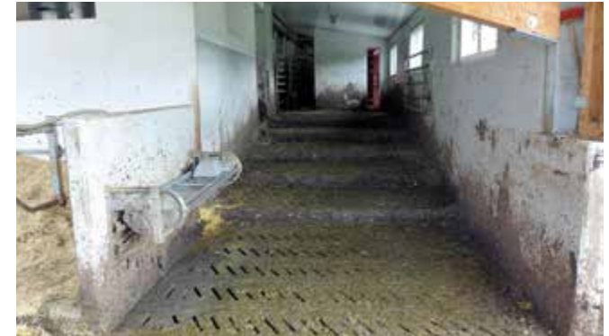
Aufgang im Inneren mit Spaltenboden mit Gummibelag
