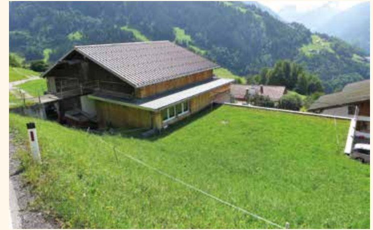
Begrüntes Dach auf dem Stallzubau
