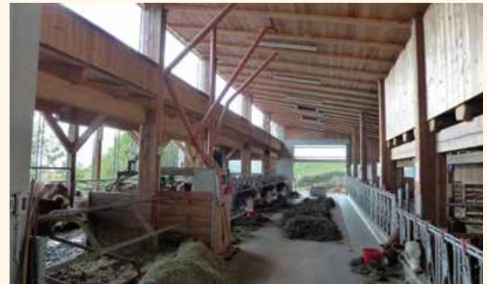
Angehobene, schräge Decke zur Verbesserung der Licht- und Luftführung
