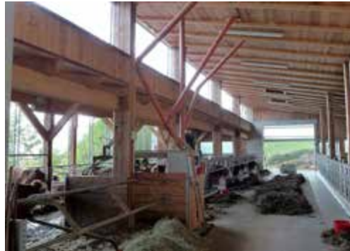
Firstentlüftung bei Zubau
