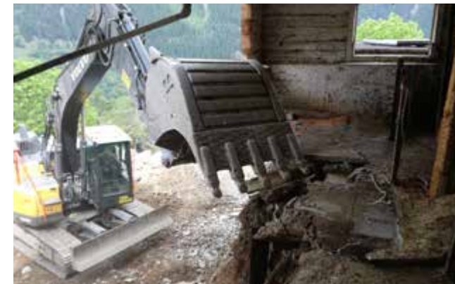
Abbrucharbeiten können sehr „tiefgreifend“ werden.
