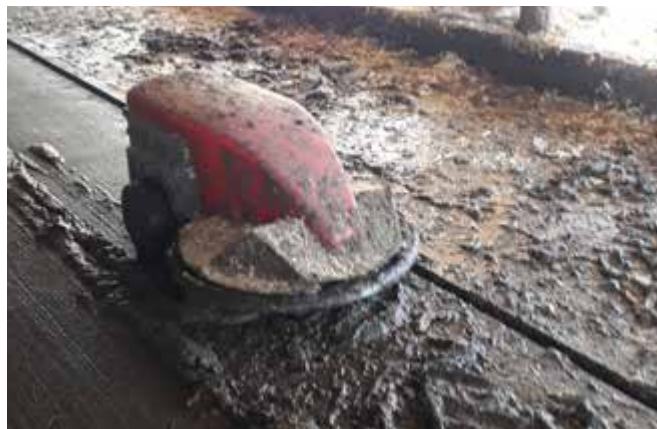
Kurze, verwinkelte Stallungen können mit einem Spaltenreinigungsroboter, kombiniert mit einem Abwurfschacht, ausreichend gut gereinigt werden.
