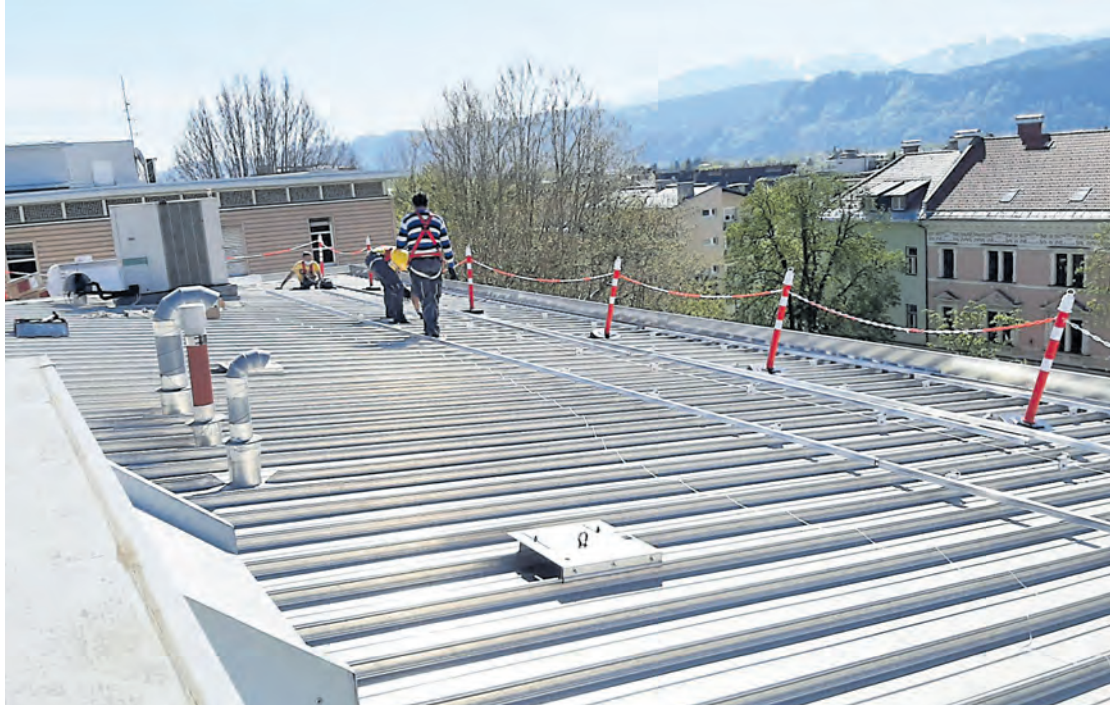
Blick über Klagenfurt bei der Montage des Unterbaus, auf entsprechende Sicherung der Monteure darf nicht vergessen werden.
