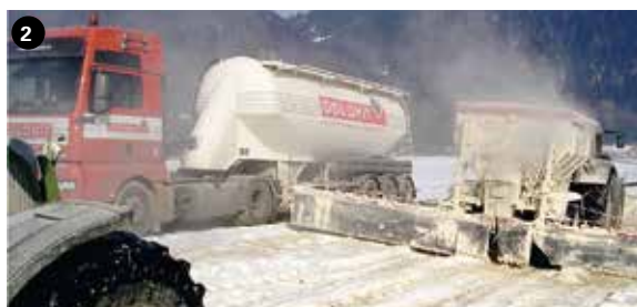
1) Kalk im Baustellen-Container
